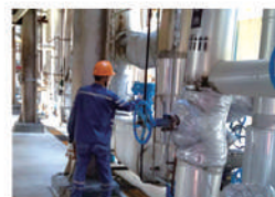
防冻凝检查是冬季防冻凝工作的重要环节，从巡检路线的制定，到每一处防冻凝情况的检查，一丝不苟，一处不漏的巡检，可以及时发现防冻凝过程中出现的问题，有效的避免冻堵的问题进一步扩大。更是在重要岗位增加防范物资，加强前置设备管线盲肠死角以及新增防冻点的防冻防凝管理，夯实安全基础管理，力求实现持续安全生产。
